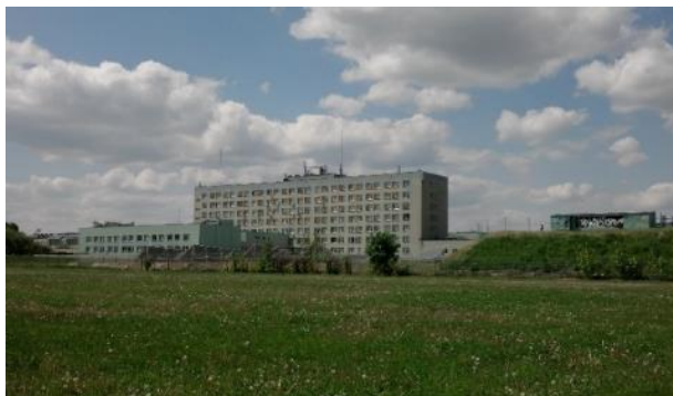
Fotografia: Mazowiecki Szpital Wojewódzki widok od strony ul. Starowiejskiej oraz widok od strony parkingu przy ul. Wiszniewskiego przed realizacją przebudowy.
