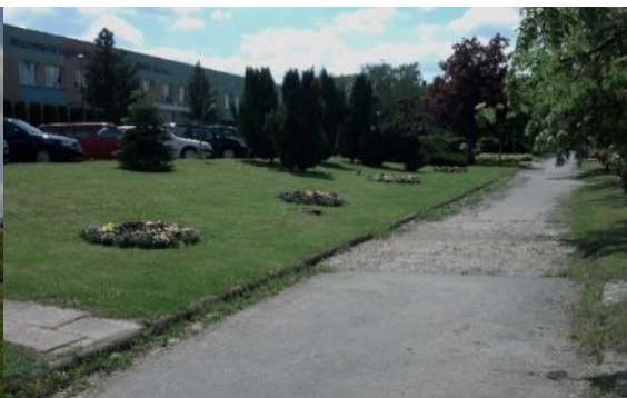
Fotografia: Zniszczony i wybrukowany ciąg pieszy przy ul. Księcia Józefa Poniatowskiego, w bezpośrednim sąsiedztwie Mazowieckiego Szpitala Wojewódzkiego przed realizacją projektu.
