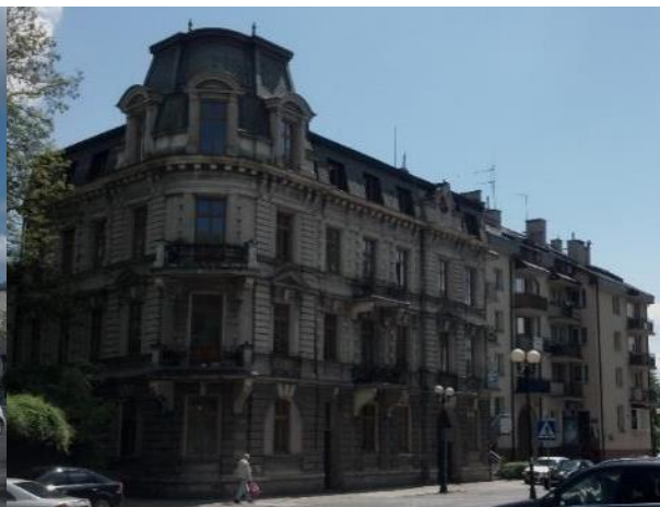
Fotografia: Kamienica przy ul. Floriańskiej
