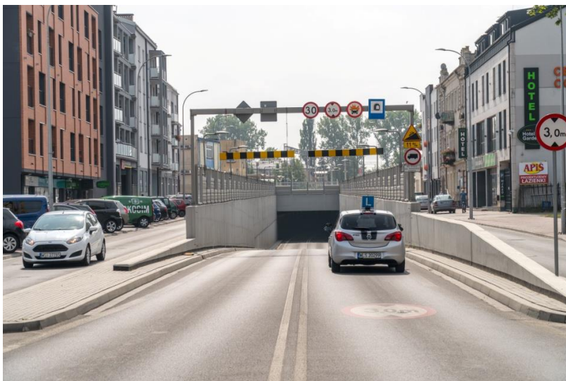
Fotografia: Wjazd do tunelu od strony ul. Kilińskiego.
