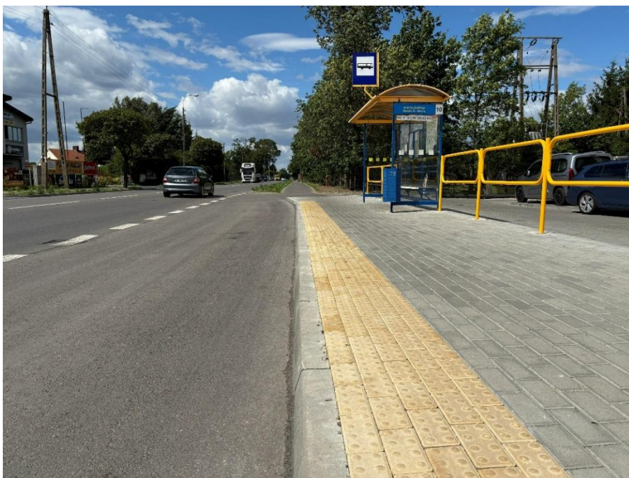
Rysunek 14. Zmodernizowana zatoka przystankowa w Siedlcach - brak pełnej dostępności dla osób niewidomych
