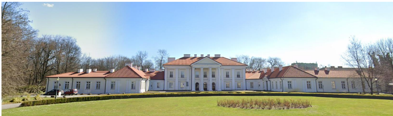
Zdjęcie nr 1. Pałac Ogińskich, ob. Uniwersytet w Siedlcach, ul. Konarskiego 2
