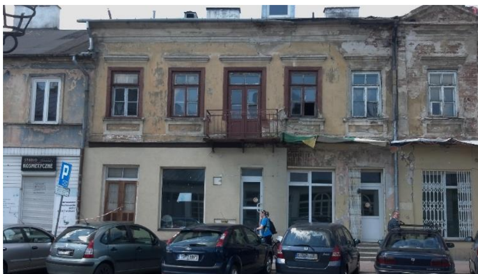
Fotografie: Zdekapitalizowane kamienice przy ulicy Esperanto
