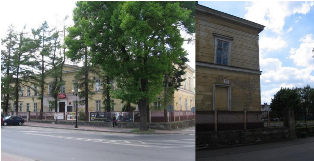
Fotografie: Widok na niszczejący budynek byłego Liceum Ogólnokształcącego – widok od wejścia przy ul. Stanisława Konarskiego oraz widok ściany bocznej i ogrodzenia od ul. Mieczysława Asłanowicza
