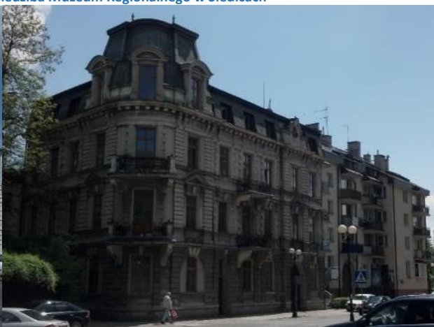
Fotografia: Kamienica przy ul. Floriańskiej
