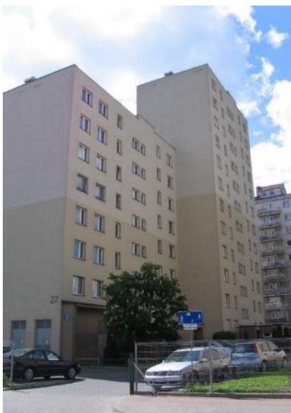
Fotografia: Osiedle blokowe przy ulicach: Józefa Formińskiego i Kolejowej
